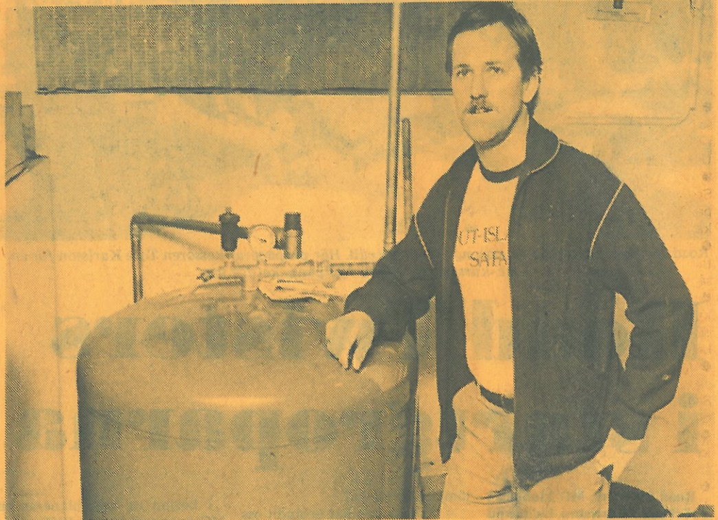
Bara genom att flytta ett expansionskärl från vinden till källaren bidrar till minskad oljeförbrukning, menar Ola Haglind, som genom åtgärder sparar minst 50 000 kr per år i fortsättningen.
